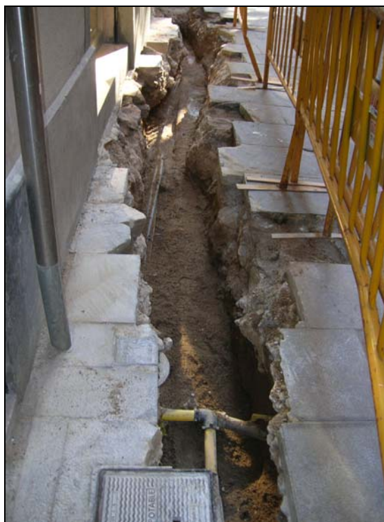
Foto 3: Obertura rasa 100 amb diversos serveis en funcionament
